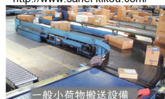
一般小荷物搬送設備
